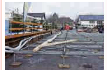
Bodenunterbau für das 600 m 2 grosse freie Eisfeld. Bild: zvg
